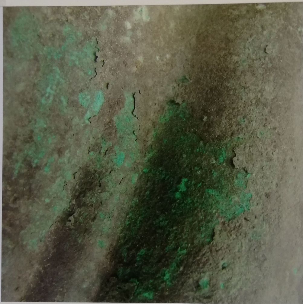
Foto 4. Moro di Sud Ovest. Il protettivo, fortemente degradato, si distacca dalla superficie.
