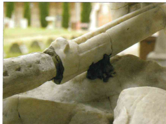
Dettaglio della canna del fucile dopo l'eliminazione dei licheni, prima dell'asportazione delle vecchie malte cementizie
