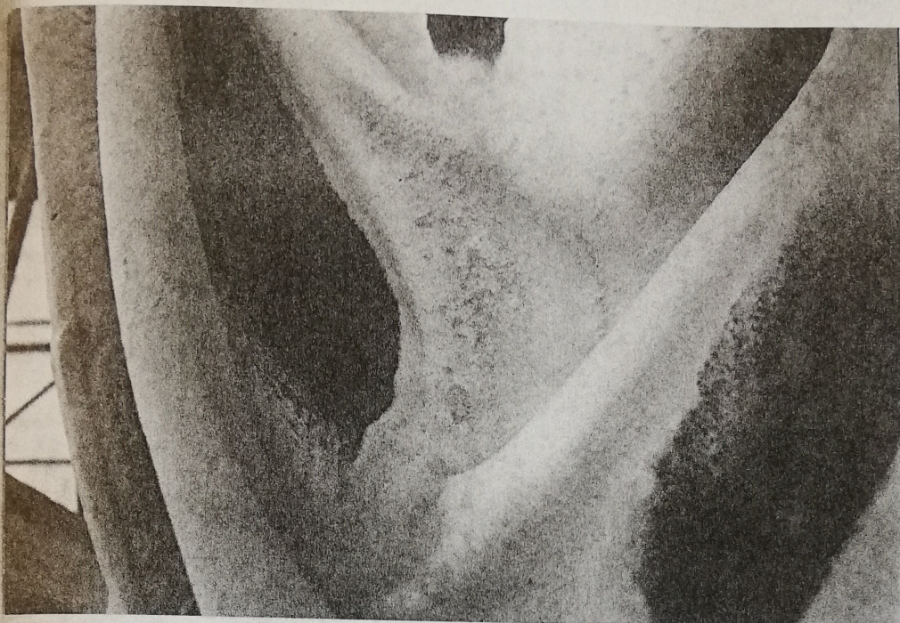
croste nere e fenomeni di decoesione della superficie marmorea
