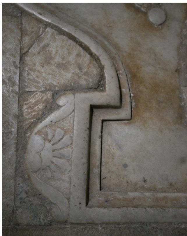
Diffusa presenza di macchie e depositi superficiali variamente coerenti
