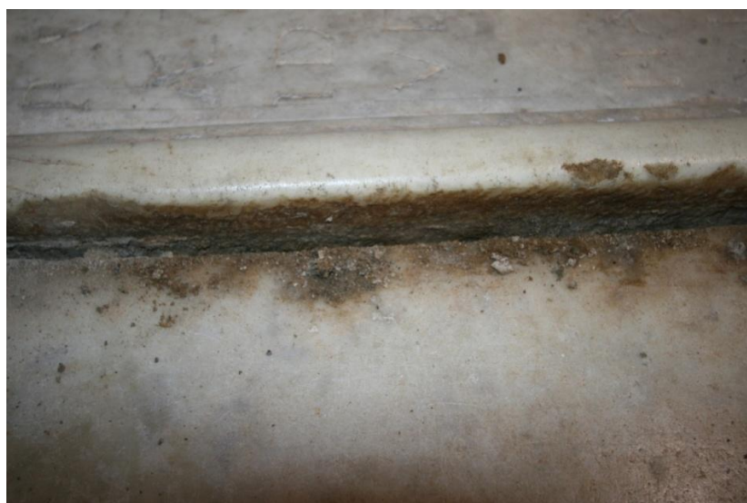
Rimozione delle stuccature non più idonee
