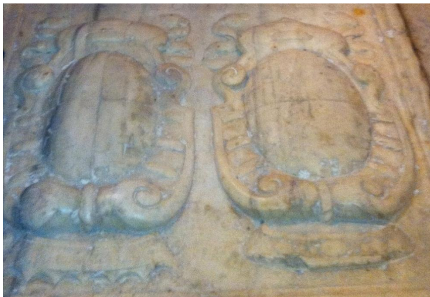
Particolare degli stemmi (prima del restauro)
