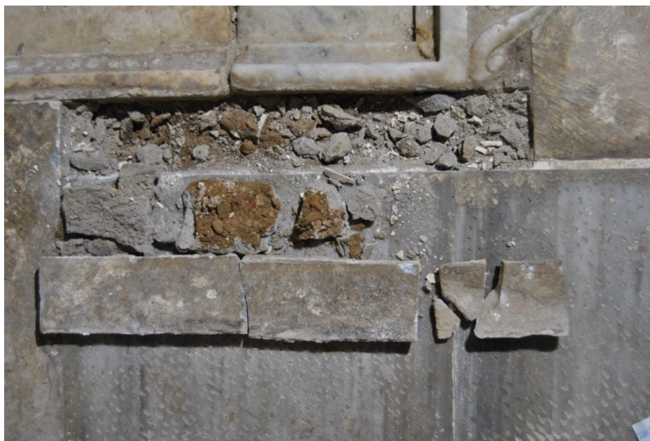
Distacco e ripristino di frammenti distaccati
