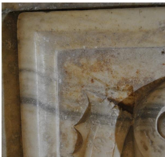
Ossidazione dei componenti minerali del marmo
