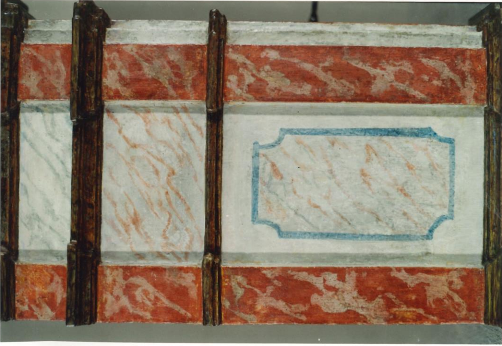
Intervento ultimato, fianco sinistro, particolare
