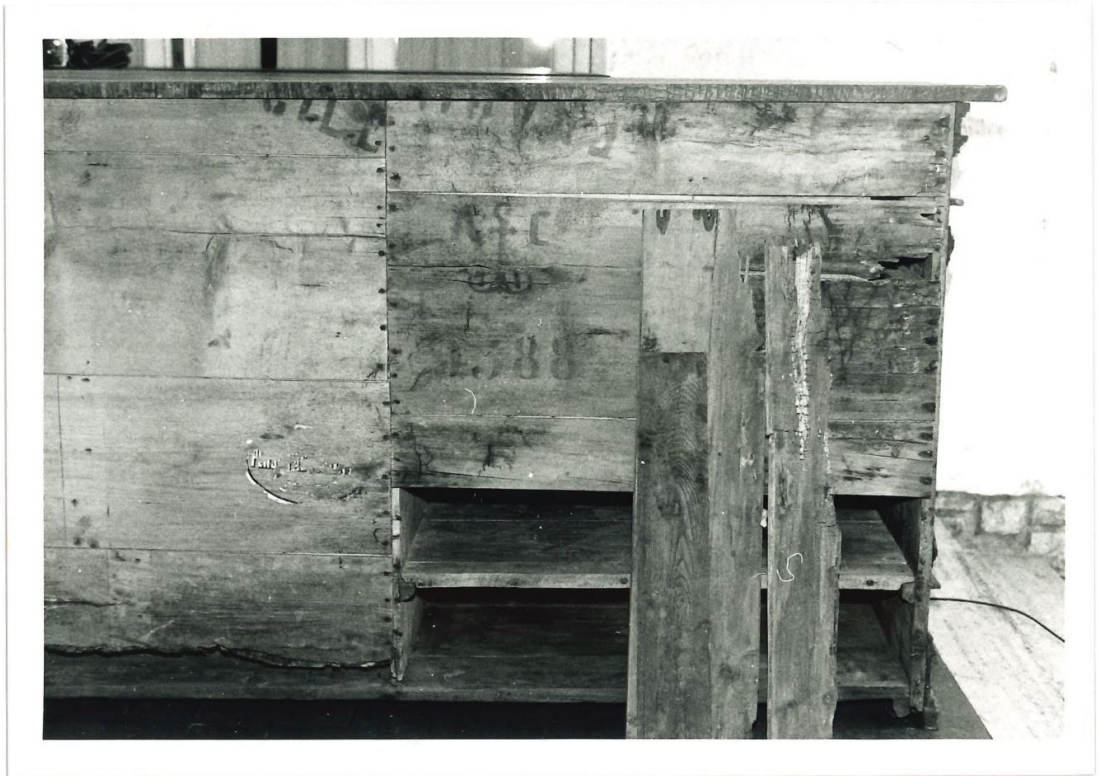
Corpo a sinistra. Retro: particolare prima dell'intervento
