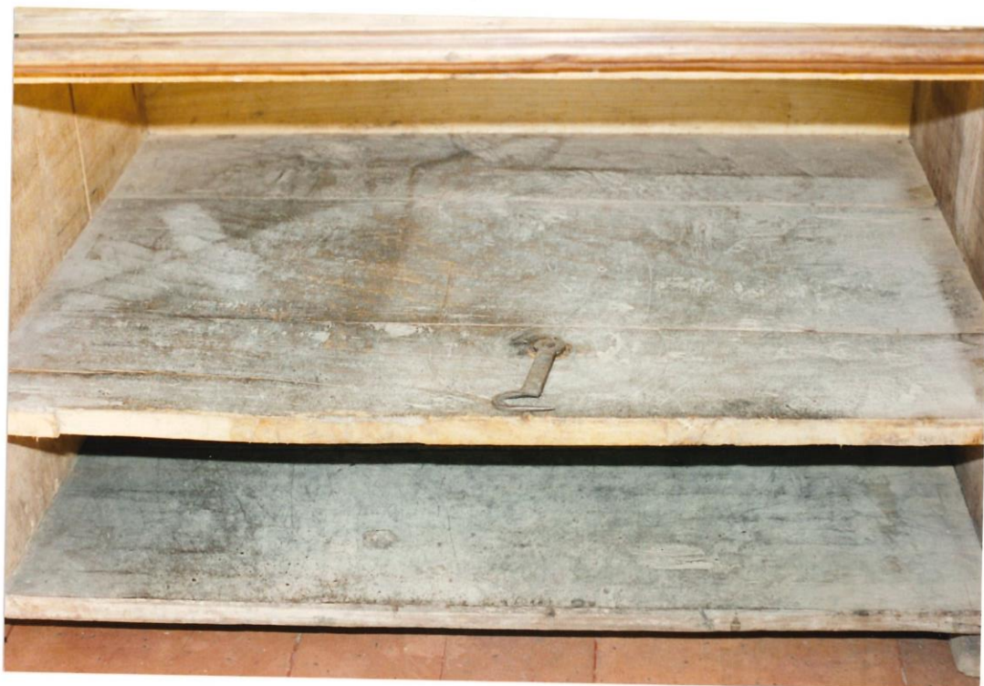
Vano interno. Particolare prima dell'intervento
