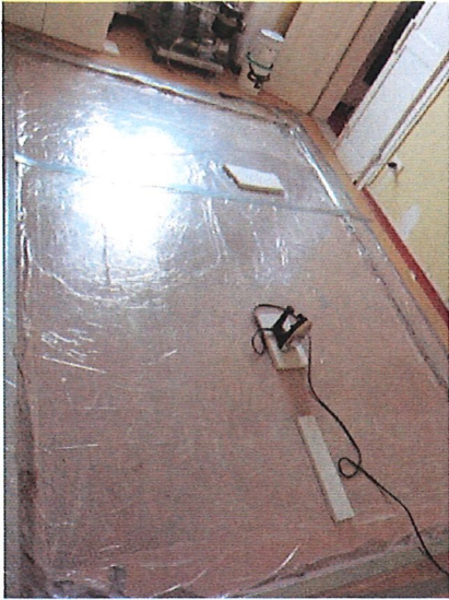
esecuzione della foderatura tramite sottovuoto
