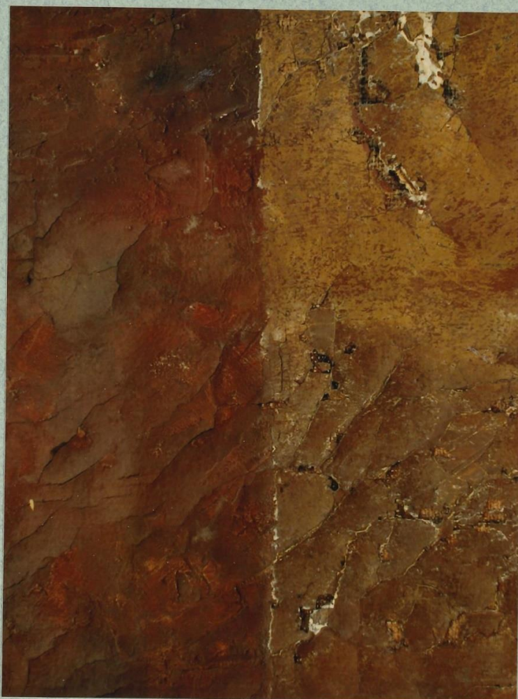
Foto 20, 21: particolari durante il restauro: stuccature dovute ad intervento precedente durante la loro rimozione
