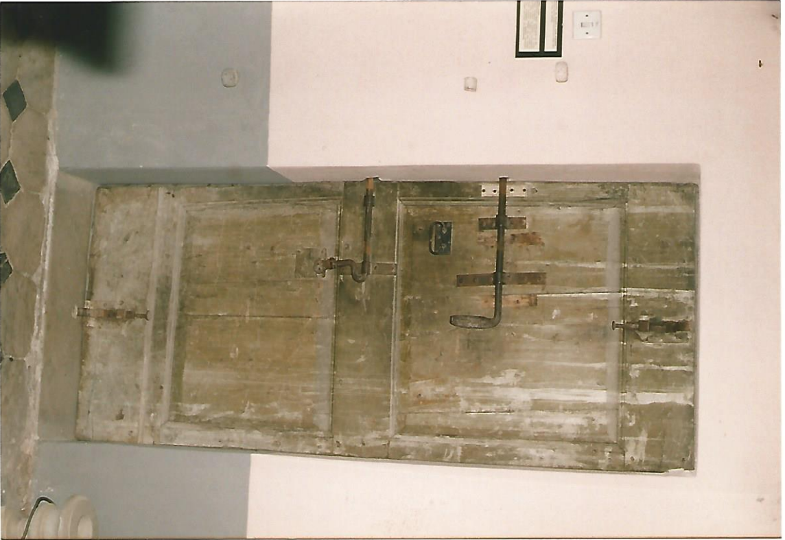
Recto, prima dell'intervento
