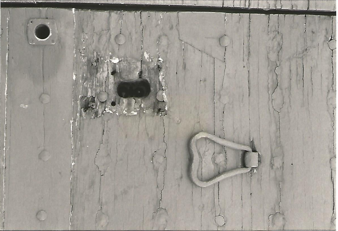
Prima dell'intervento, particolare
