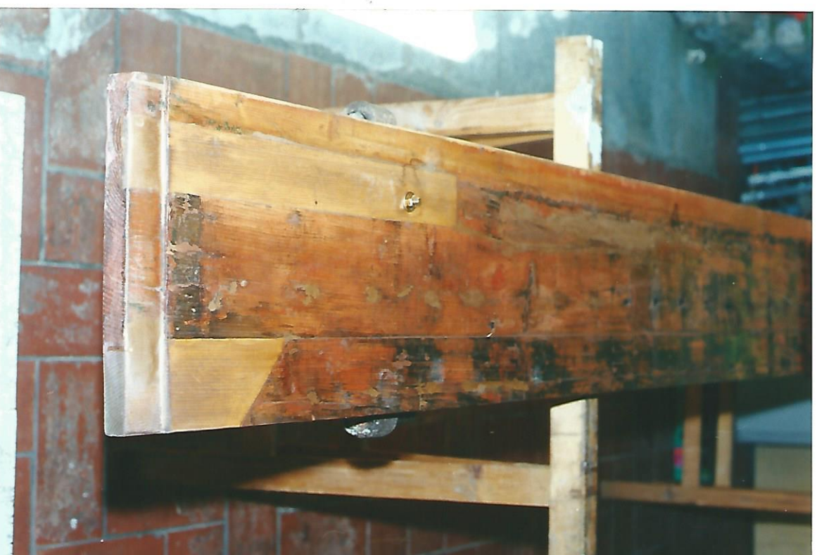
Idem, dopo le integrazioni e la stabilizzazione strutturale dell'assito interno
