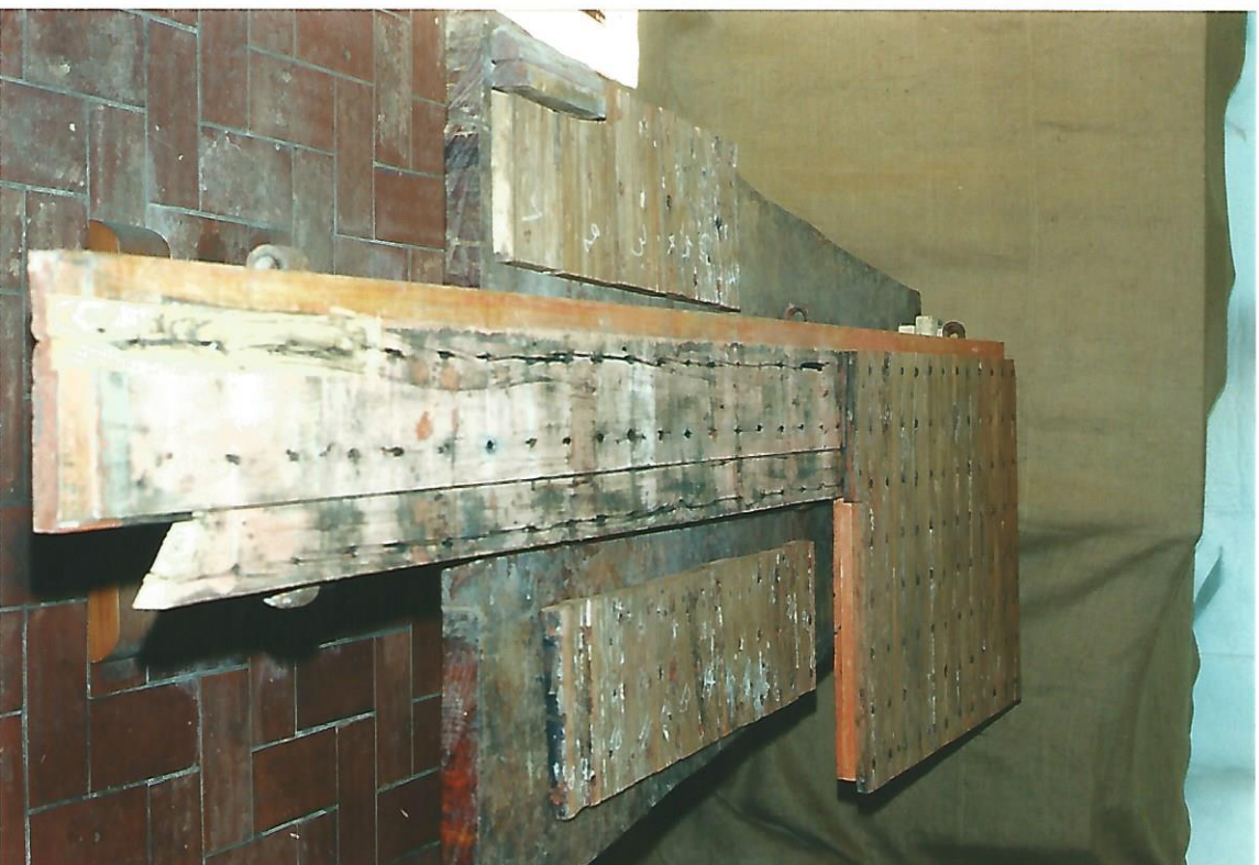
Anta sinistra, durante lo smontaggio delle tavole esterne, con tagli per le integrazioni dell'assito interno
