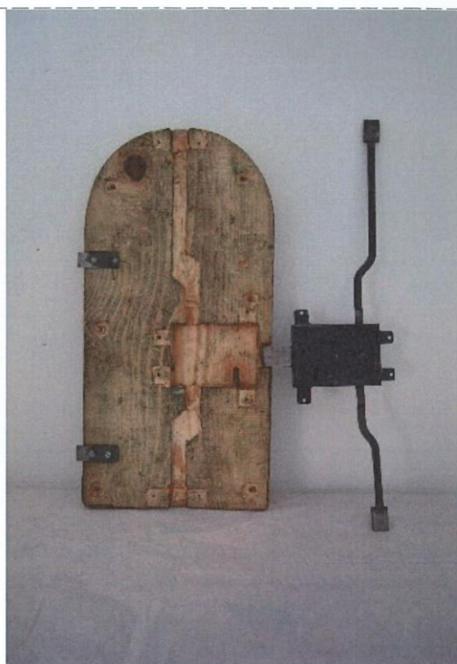
L'anima lignea ed il sistema di chiusura in ferro battuto durante la pulitura
