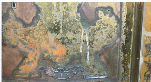
Particolare dei sali di rame e dell'aspetto superficiale della lamina d'ottone dorato
