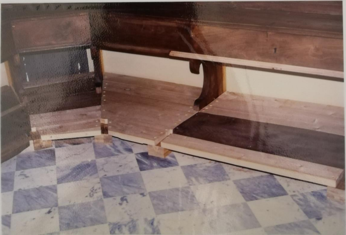
Particolare pavimentazione, durante il montaggio
