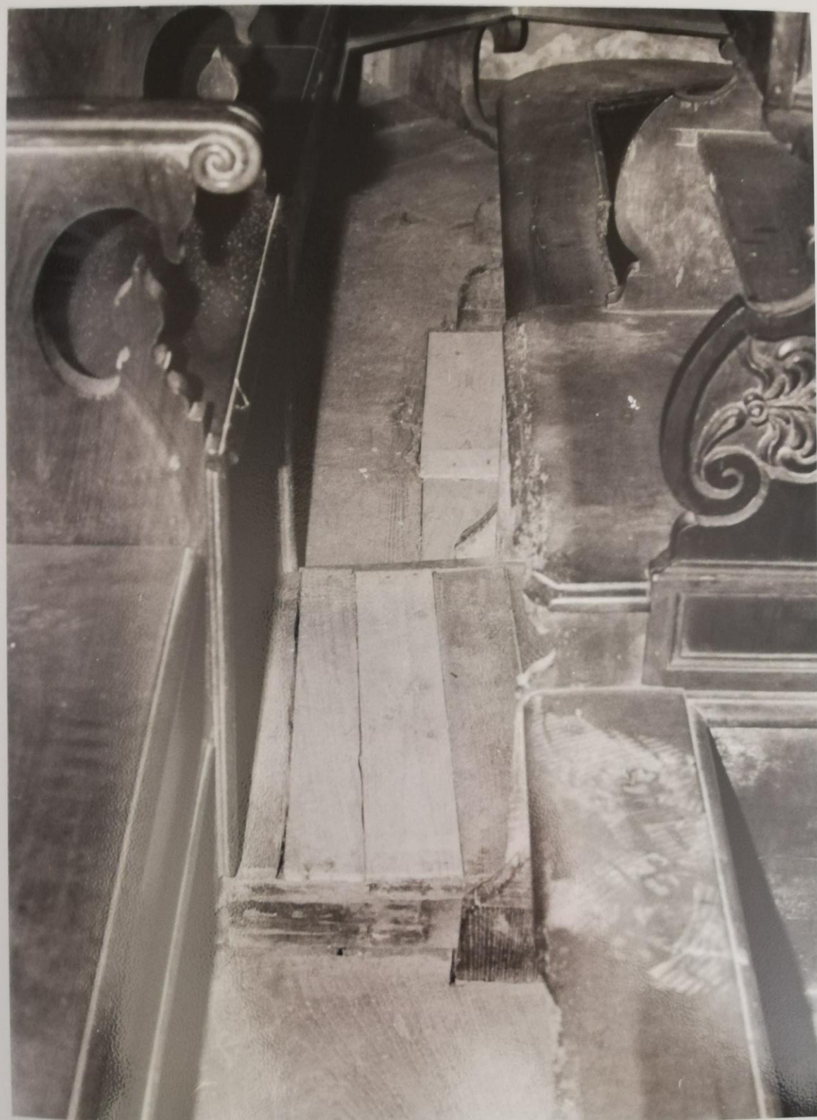
Particolare pavimentazione, stato precedente
